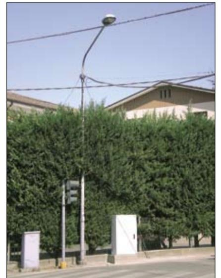
■ ■ ■ Armatura stradale da 150 W con regolatore di flusso luminoso telecontrollato
