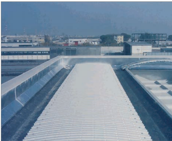
fase di montaggio
