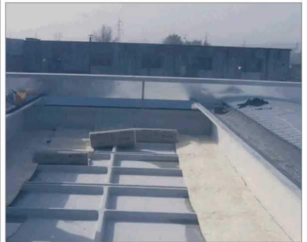
montaggio dell' isolamento termico
